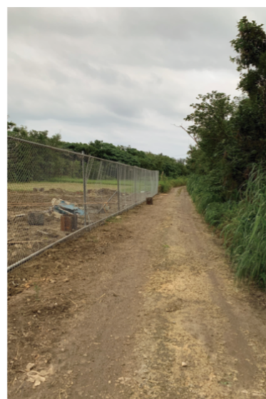
施行中のフェンスと道路
